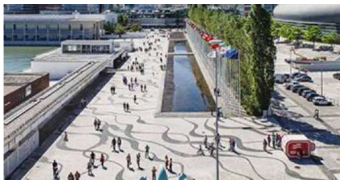
Lo spaccato indistintamente utilizzato per porzioni pedonali e carrabili a costituire un grande manto uniforme: l'esempio di Lisbona
