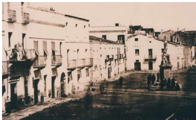
Foto storica che evidenzia la presenza di marciapiedi in pietra su pavimentazioni di terra.
