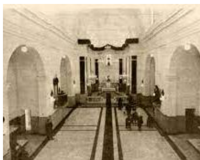
Foto storica interno della chiesa di San Carlo Borromeo di Carloforte. Riferimento progettuale sull'uso dello schema geometrico nei pavimenti interni con diverse cromie
